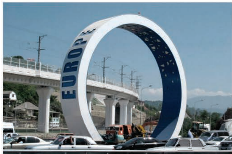
Road interchange «Adler ring» 2012
